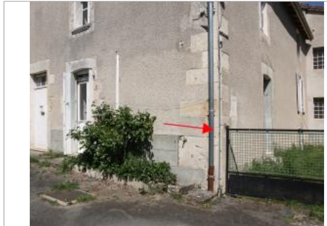
Site rue des Lavandières (1)
