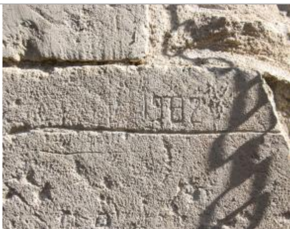
Marque 1982 sur bâtiment amont
