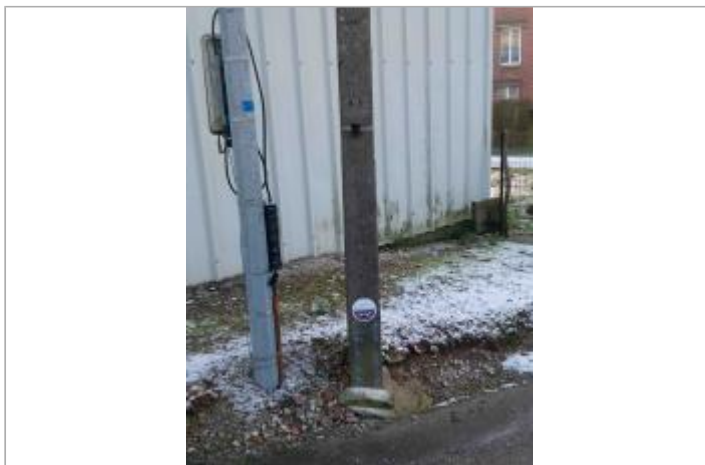
site du repère
