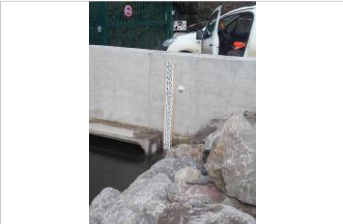
site du repère
