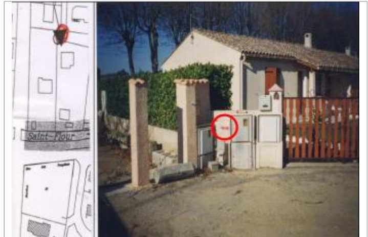
Muret à gauche de l'entrée près des coffrets EDF
