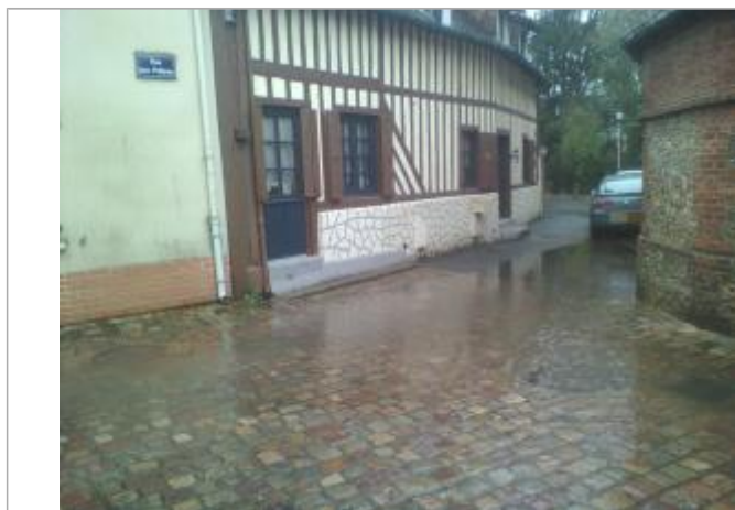
Niveau d'eau a atteint la deuxième pierre du secteur pavé devant le seuil de la porte (Photo: DST Pont-l'Évêque)
