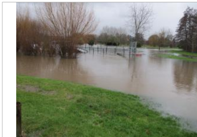
Niveau d'eau sur les premiers centimètres de la structure de soutien (Photo: DST Pont-l'Évêque)
