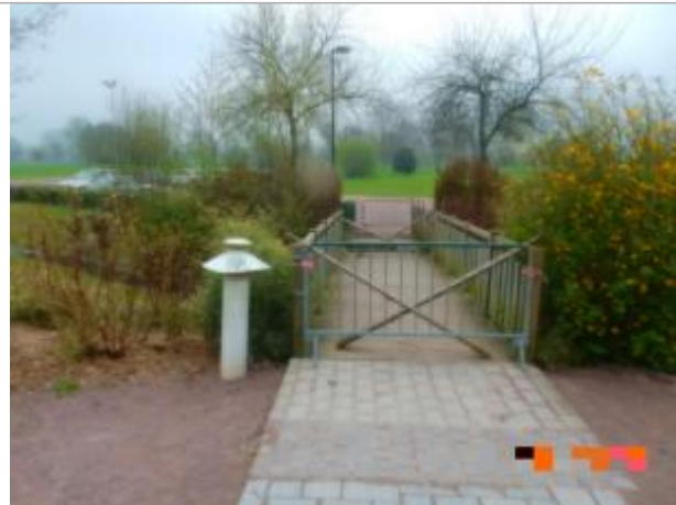
Photo de la passerelle en cours de rénovation (Photo: SPC SACN)
