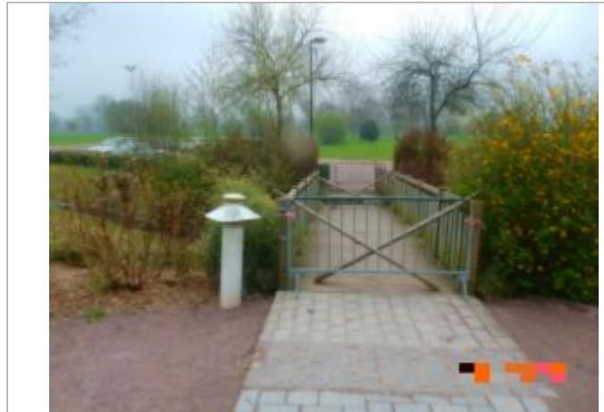
Photo de la passerelle en cours de rénovation (Photo: SPC SACN)
