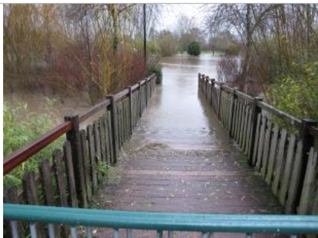
Niveau d'eau au niveau d'une des planches plus claires (Photo: DST Pont-l'Évêque)
