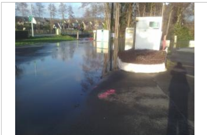
Niveau d'eau atteint par le débordement au niveau du poteau en bois (Photo: DST Pont-l'Évêque)
