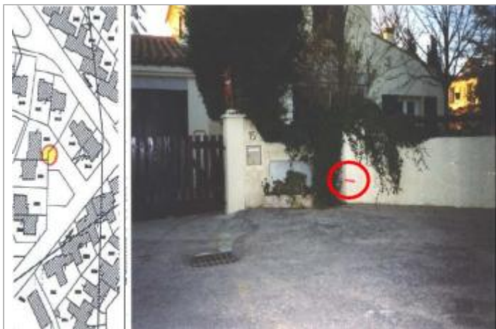
Mur de clôture
