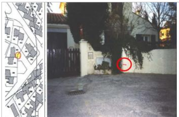
Mur de clôture
