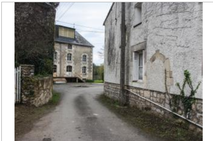
Maison du 6 rue du moulin
