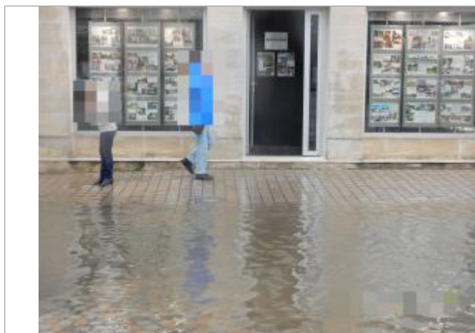
Niveau maximum atteint par le ruissellement au 1 rue Hamelin (Photo SPC SACN)
