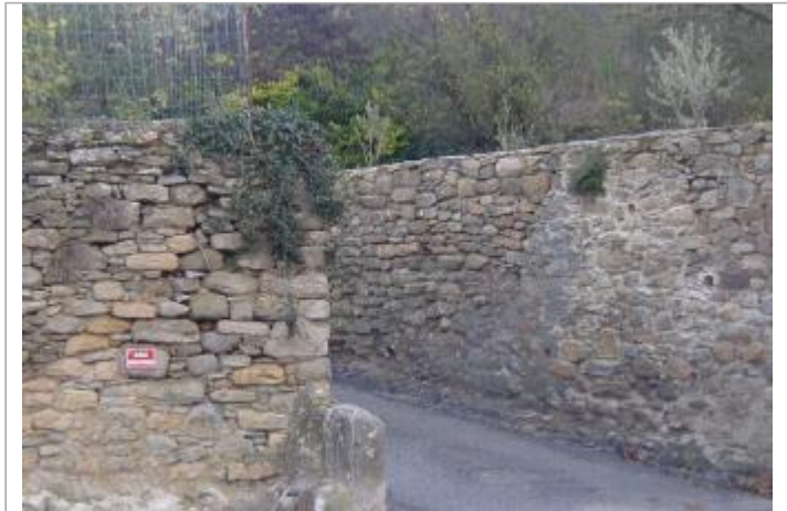
Mur de clôture
