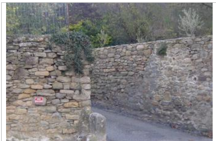
Mur de clôture
