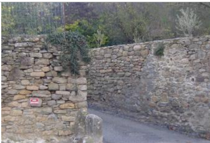
Mur de clôture
