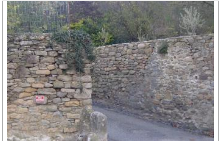
Mur de clôture
