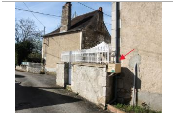
Site 7 rue du port
