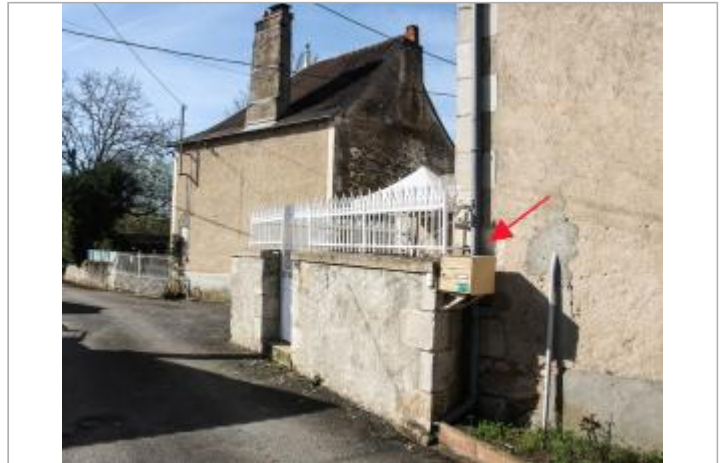
Site 7 rue du port
