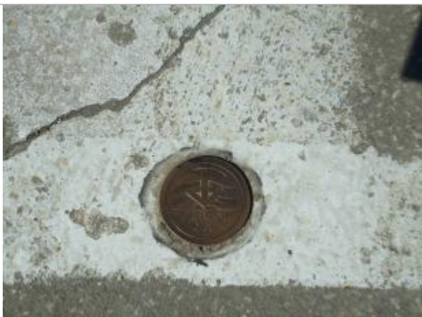
Repère Xynthia - Chemin du Pas des huîtres
