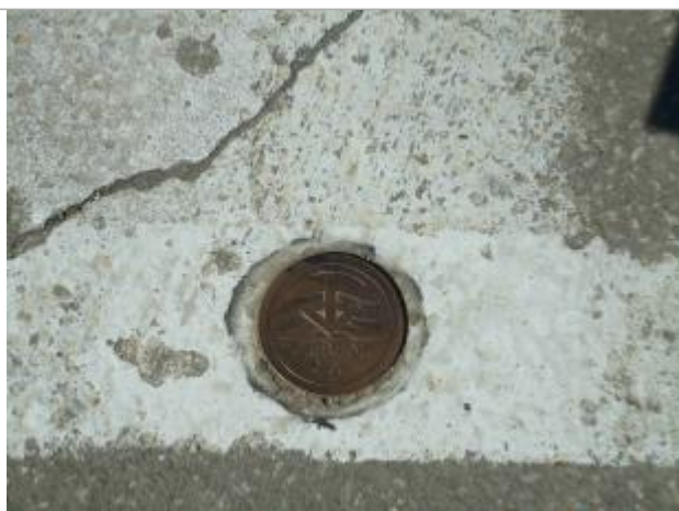
Repère Xynthia - Chemin du Pas des huîtres
