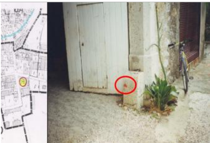
pilier du portail de la cave
