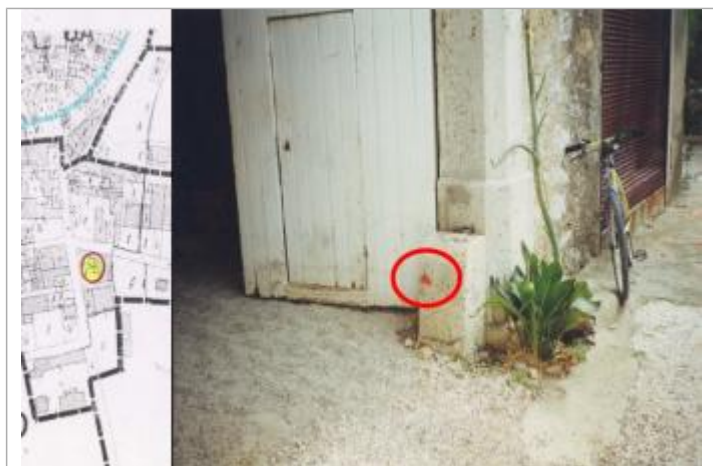
pilier du portail de la cave
