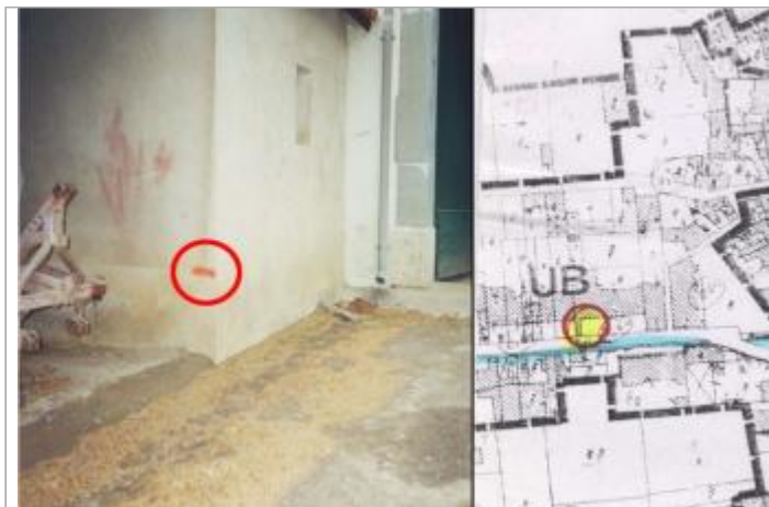
façade de garage
