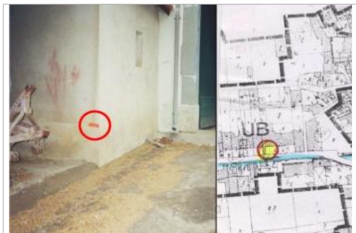
façade de garage
