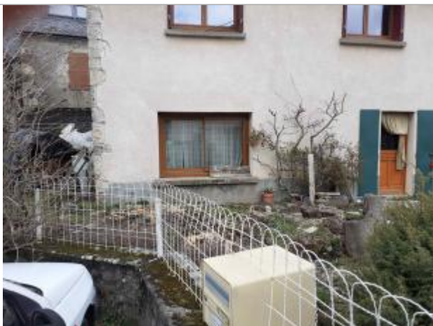
Repère Xynthia - Rue de la Maladrerie
