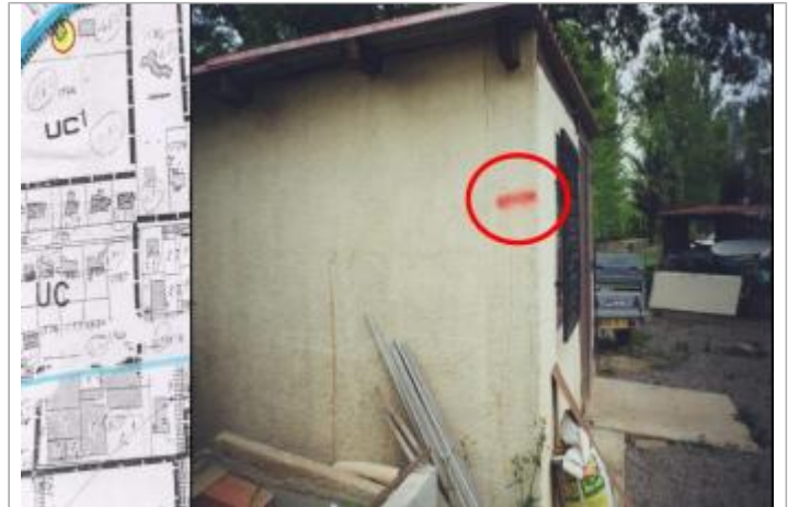
Façade abri de jardin
