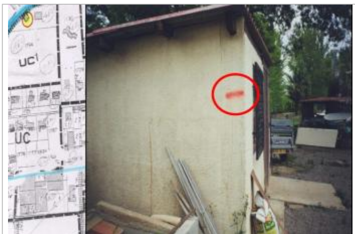
façade abri de jardin
