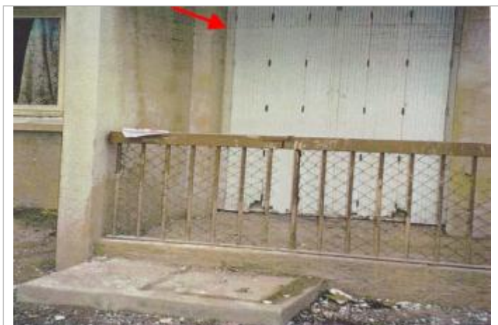
Sol du balconnet
