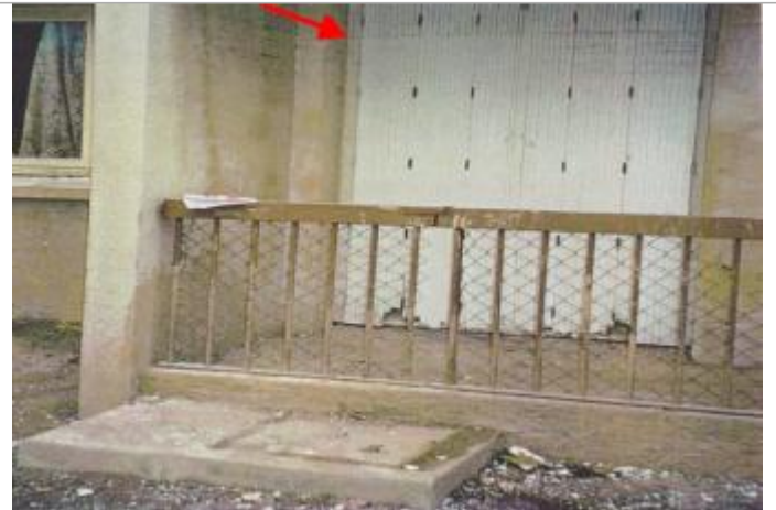
Sol du balconnet
