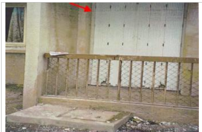
Sol du balconnet
