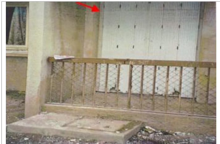
Sol du balconnet
