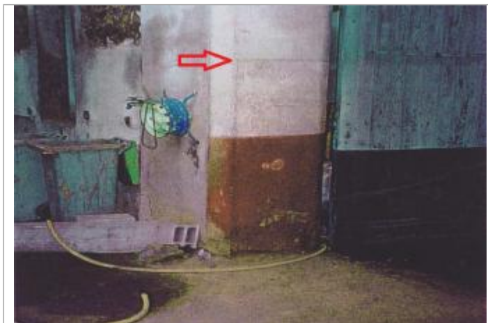
Pilier de garage
