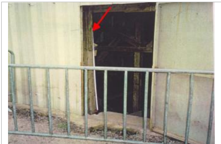
dalle sous les gradins
