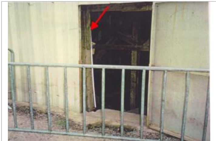
dalle sous les gradins
