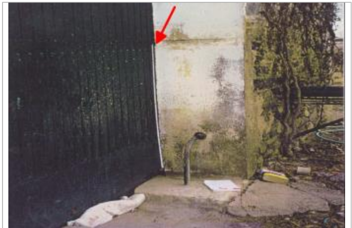
seuil porte garage
