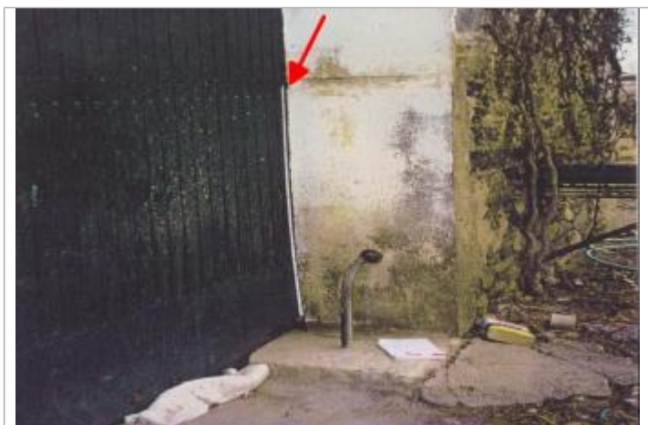
seuil porte garage
