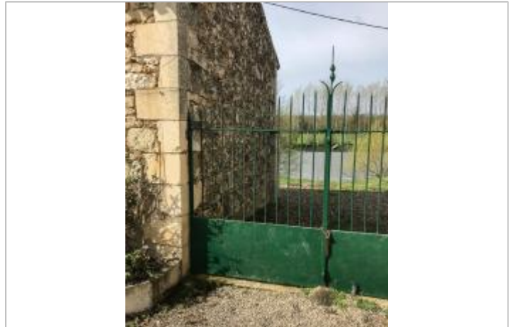
Le Grand Felin - marques dans l'angle du mur
