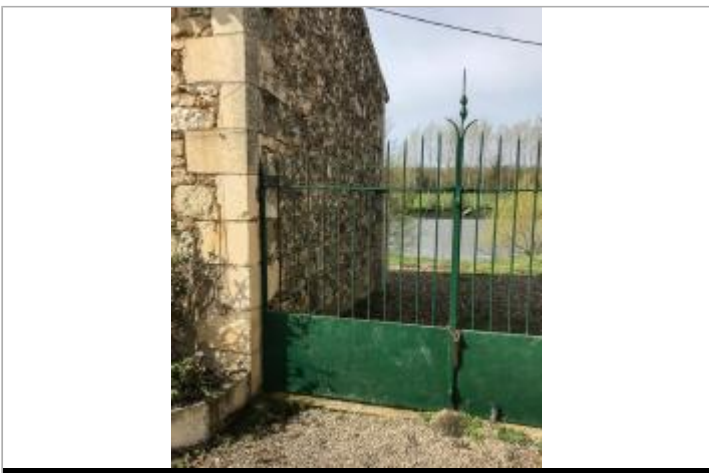
Le Grand Felin - marques dans l'angle du mur
