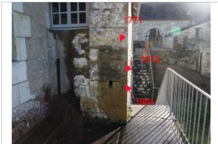
Mur pignon Ouest - face rivière
