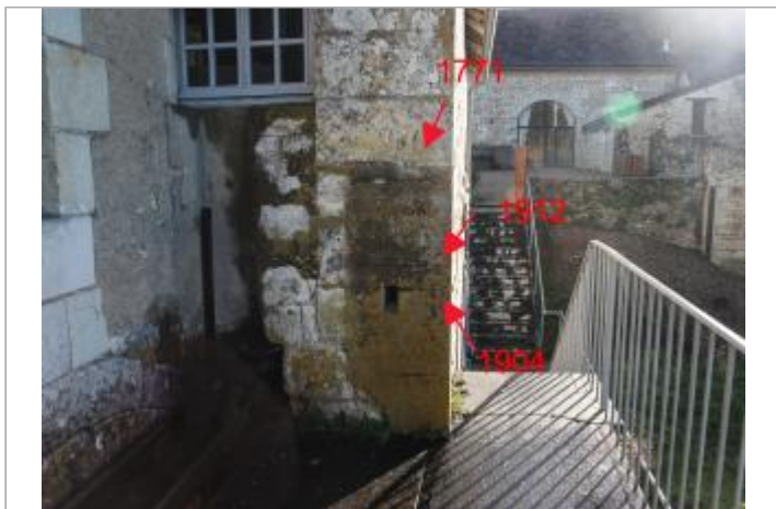
Mur pignon Ouest - face rivière
