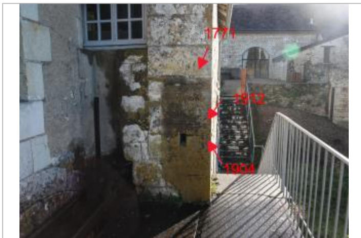
Mur pignon Ouest - face rivière
