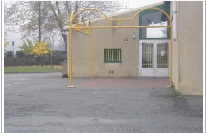
niveau du parking devant la porte d'entrée
