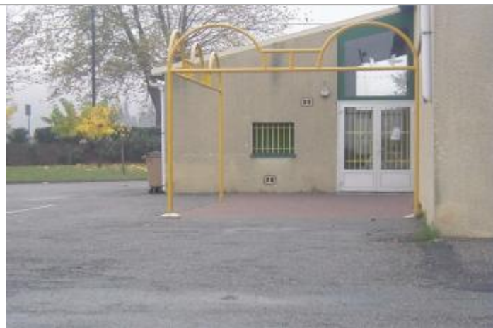
niveau du parking devant la porte d'entrée
