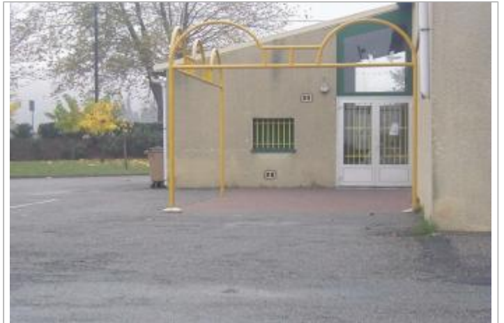
niveau du parking devant la porte d'entrée
