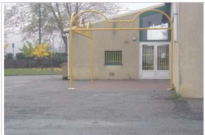
niveau du parking devant la porte d'entrée
