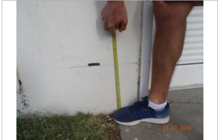
Vue de la PHE - Auteur : Cerema et témoignages
