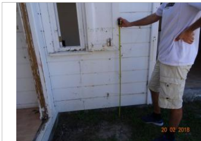
Vue de la PHE - Auteur : Cerema et témoignages
