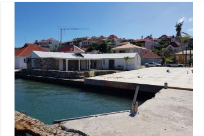
Vue du site - Auteur : Cerema et témoignages
