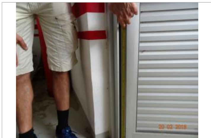
Vue de la PHE - Auteur : Cerema et témoignages
