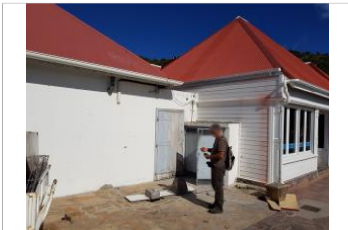
Vue du site - Auteur : Cerema et témoignages
