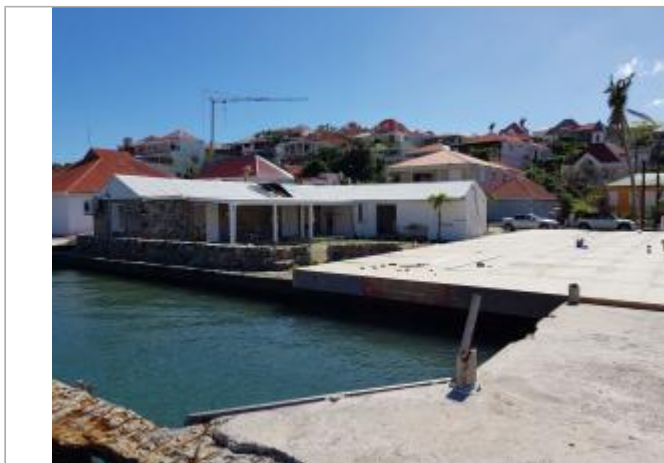
Vue du site - Auteur : Cerema et témoignages
