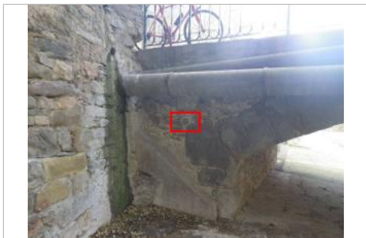
Macaron face aval du pont
