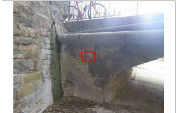
Macaron face aval du pont
