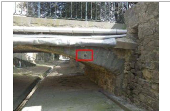
Macaron face amont du pont
