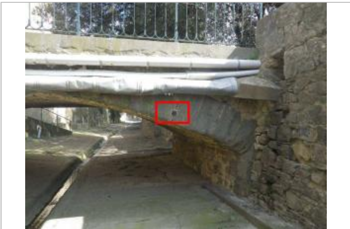
Macaron face amont du pont
