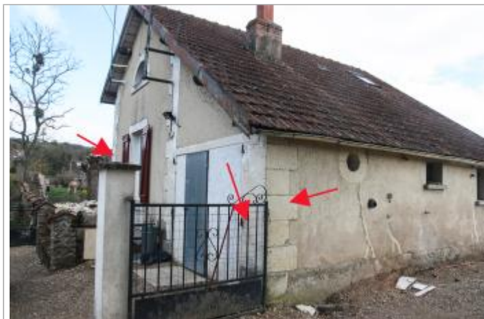
Repères au lieu dit "Le Roc"
