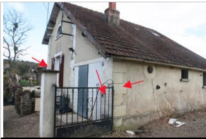
Repères au lieu dit "Le Roc"
