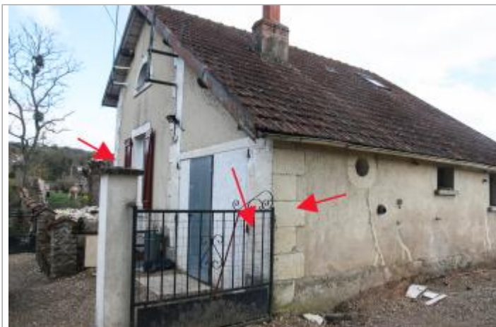
Repères au lieu dit "Le Roc"
