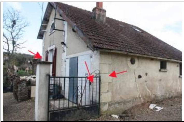
Repères au lieu dit "Le Roc"
