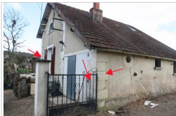
Repères au lieu dit "Le Roc"
