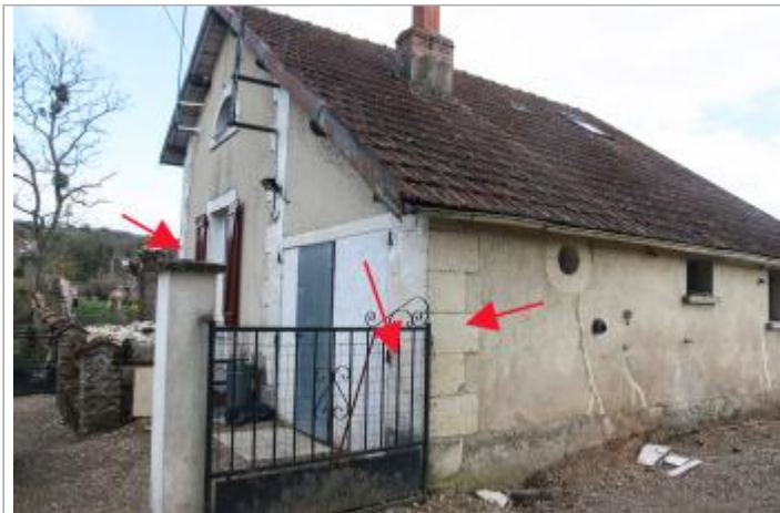
Repères au lieu dit "Le Roc"
