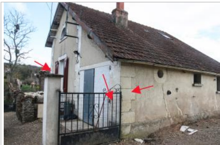
Repères au lieu dit "Le Roc"
