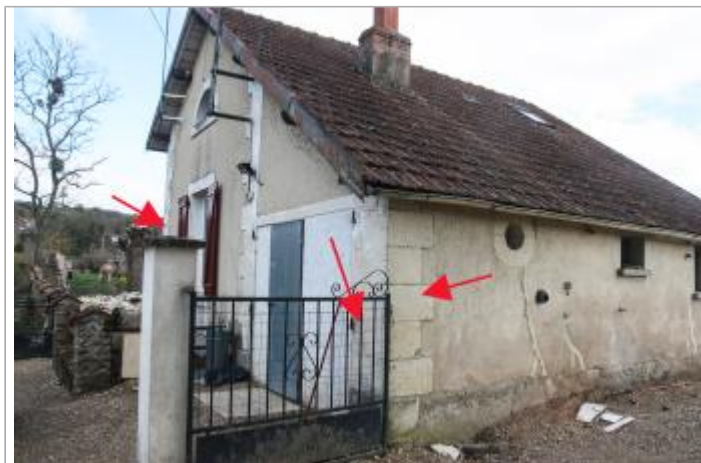
Repères au lieu dit "Le Roc"
