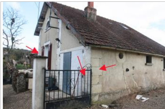
Repères au lieu dit "Le Roc"
