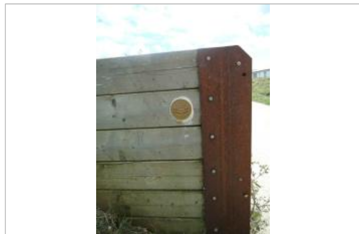
Repère Xynthia - Route du Pertuis
