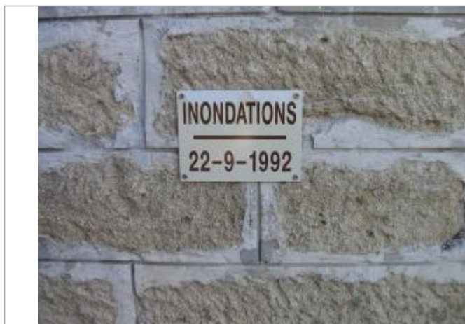
Repère de crue de l'Ouvèze
